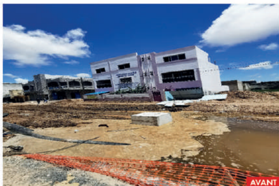
Branche 6 avant et après réalisation des travaux
