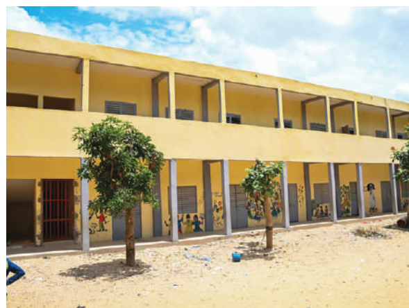
Construction de salles de classe à Thiès Est
